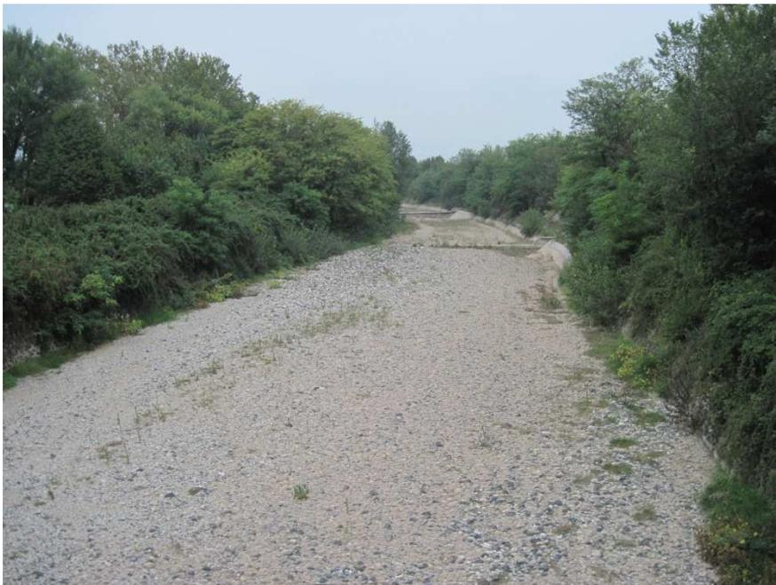
Il fiume Guà da SP33 vista monte (b). si nota come le briglie a monte di SP33 siano completamente interrate a causa del trasporto solido del fiume.
