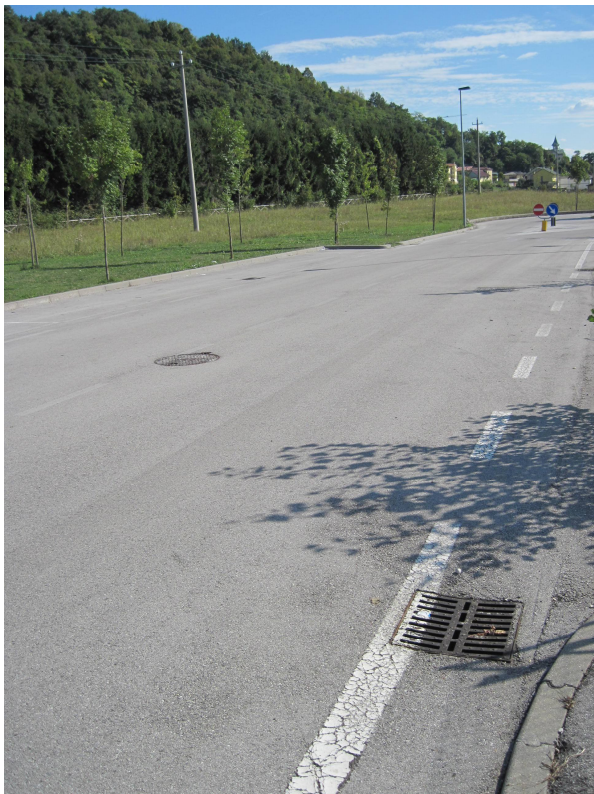
Le opere di urbanizzazione con, in primo piano, il sistema di collettamento delle acque meteoriche
