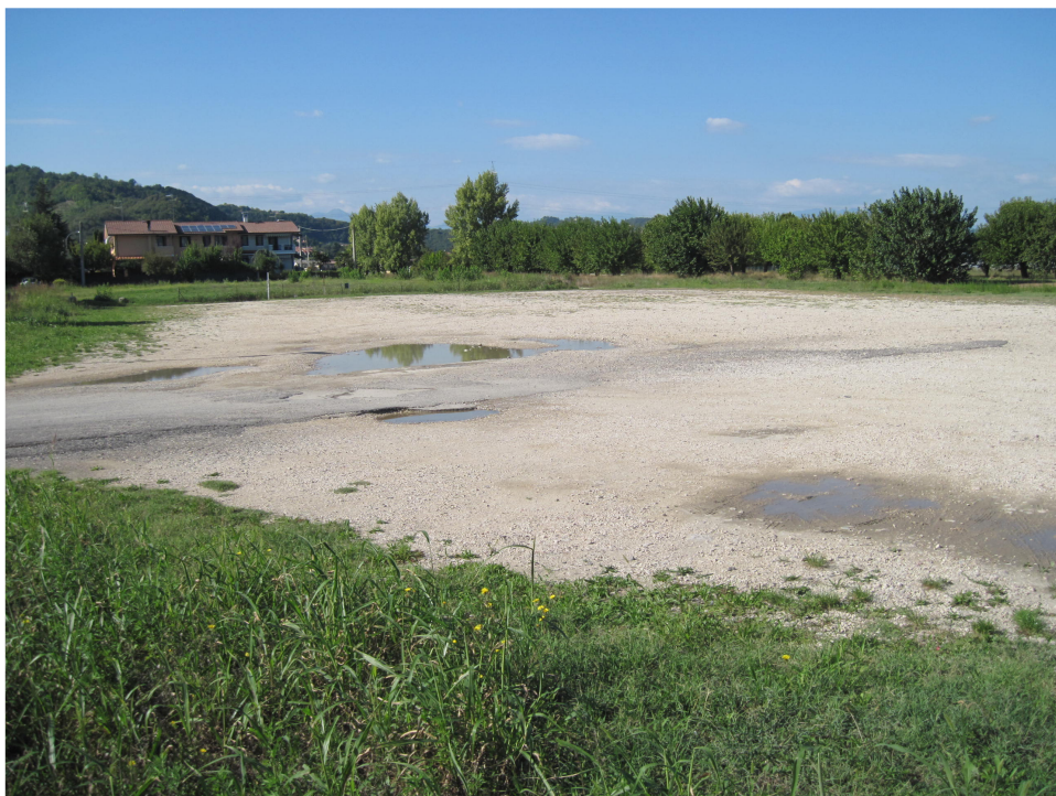
Parte dell'area oggetto di intervento, ora piazzale in misto stabilizzato
