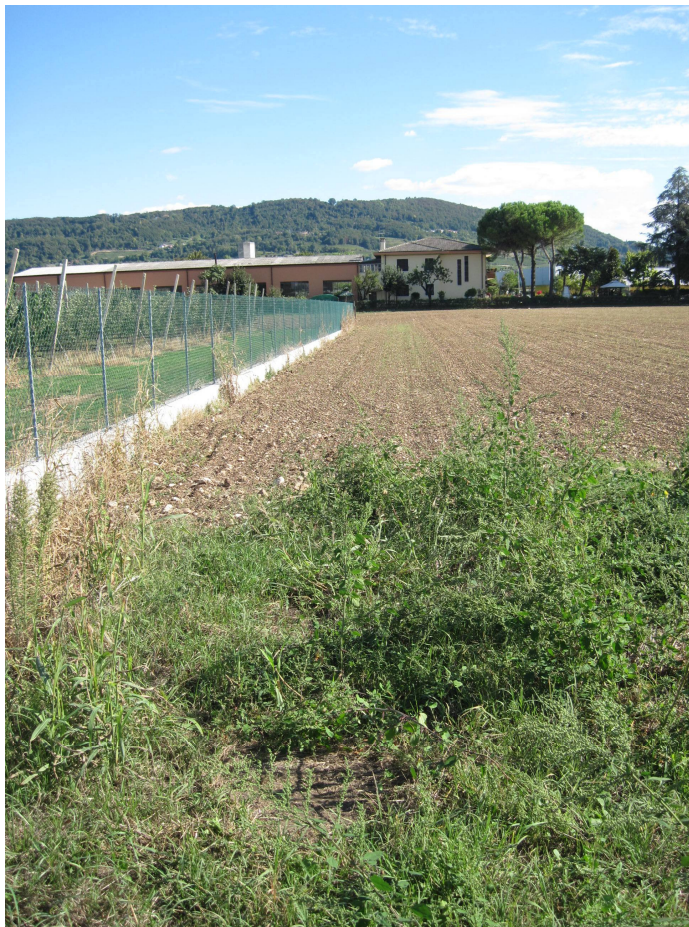
Foto dell'asse di scorrimento della rete fognaria bianca. In primo piano (poco visibile vista la vegetazione) il chiusino di ispezione
