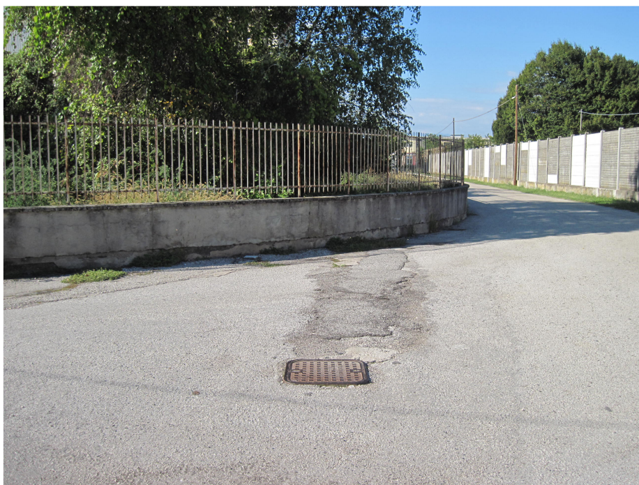
Tracciato della rete fognaria locale fuori dall'ambito. È evidente lo scavo di congiungimento del pozzetto verso l'area "ex Faeda"
